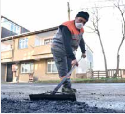
Orhanlı Mahallesi Özkan Sokak
