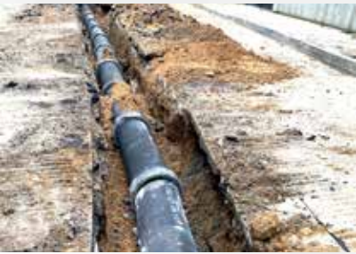
Evliya Çelebi Mahallesi Ecehan Sokak
