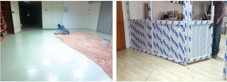
Gönül Elleri Çarşısı Zemin Kaplama Ve Bölme Duvar İmalatı
