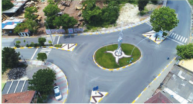
İSTASYON KAVŞAĞI SAAT KULESİ YAPIMI
