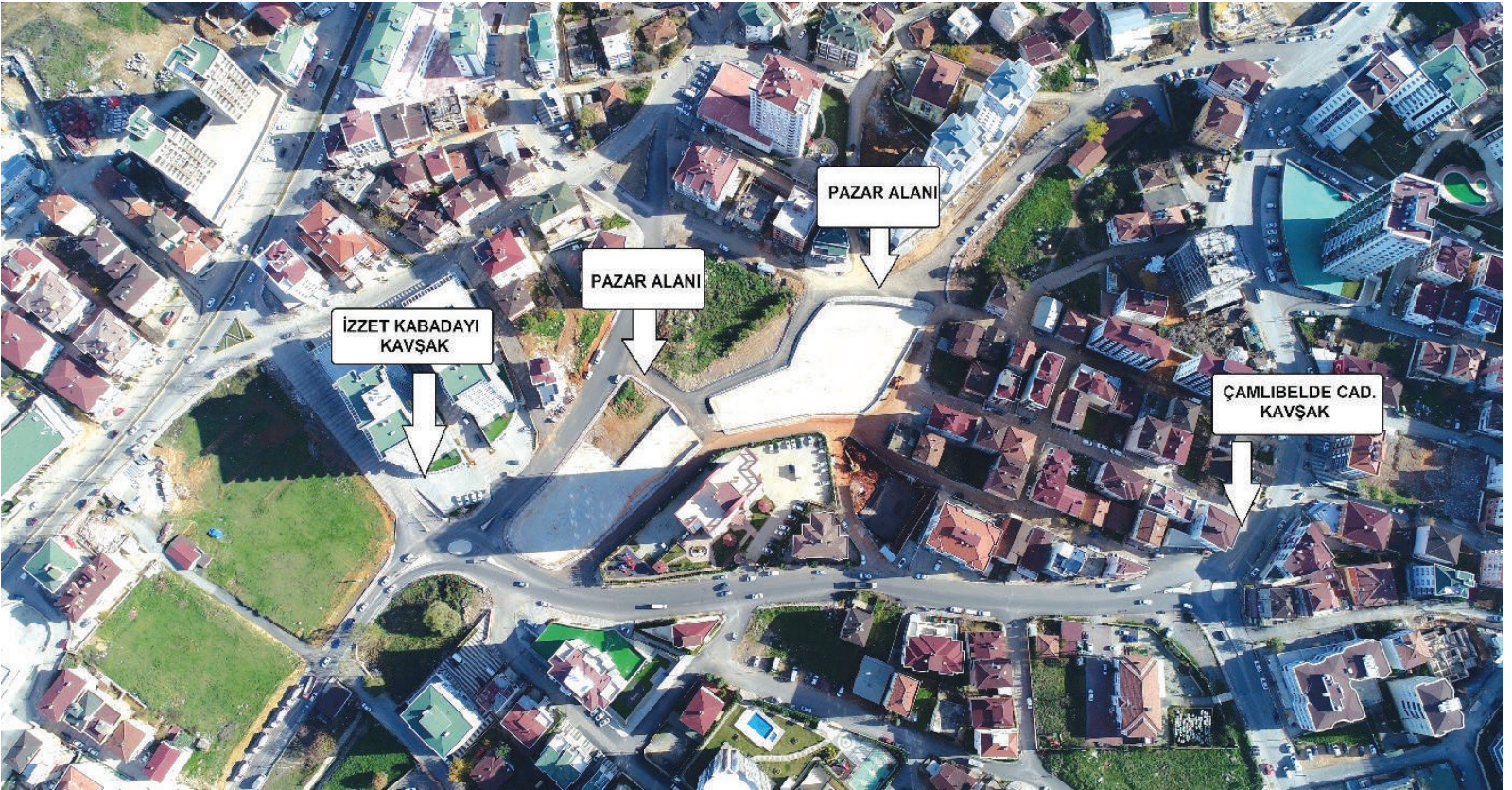
AYDINLI MAHALLESİ İZZET KABADAYI SOKAK VE ÇAMLI BELDE CADDESİ KAVŞAK ÇALIŞMALARI
