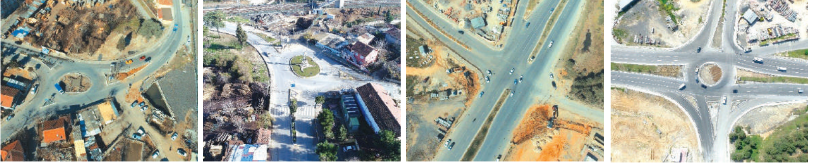
İSTASYON MAHALLESİ HATBOYU CADDESİ VE İSTASYON CADDESİ KESİŞİMİ KAVŞAK ÇALIŞMASI
