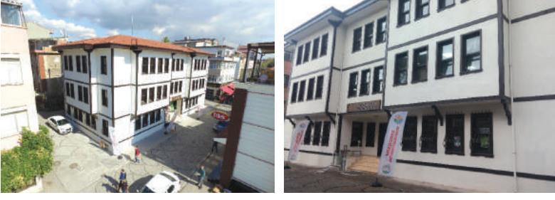
Postane Mahallesi Ek Hizmet Binası
