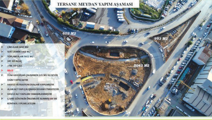
TERSANE MEYDAN YAPIM AŞAMASI
