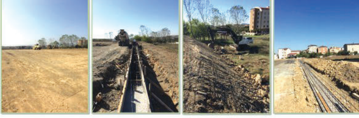
MESCİT MAHALLESİ AÇIK SAHA YAPIM AŞAMALARI
