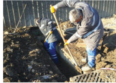
Tuzla Geneli Muhtelif Cadde Ve Sokaklarda Yağmursuyu Baca Ve Izgara imalatı
