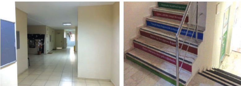
İçmeler Bilgi Evi Boya Ve Korkuluk İmalatı
