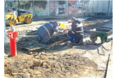
Tuzla Geneli Muhtelif Cadde Ve Sokaklarda Yağmursuyu Baca Ve Izgara imalatı
