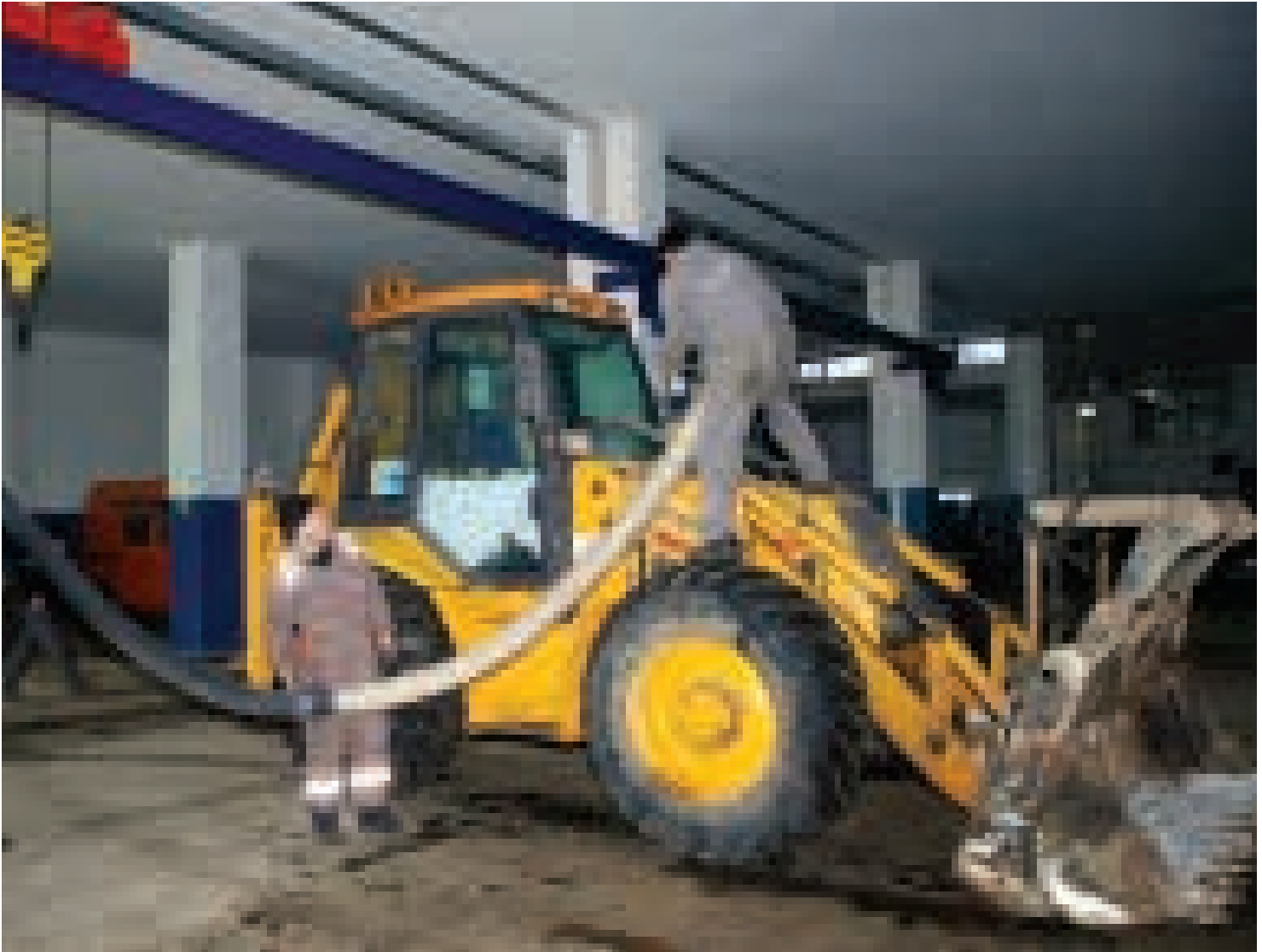
Makine İkmal ve Bakım Onarım Bölümünde Bakım Onarım Çalışmaları
