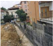
Duvar ( kalıp, beton ) çalışması
