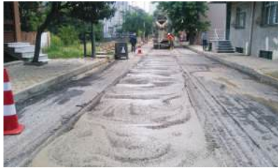
YAYLA MAHALLESİ ÖZTUNÇ SOKAK
