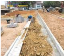
Bordür, şev taşı uygulaması
