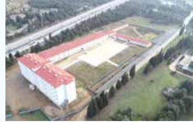
Piyade Okulu Komutanlığı Hizmet Binaları Yapım İşİ
