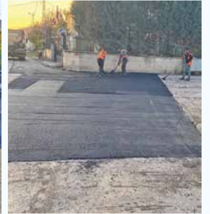
Orhanlı Mahallesi İrfan Caddesi
