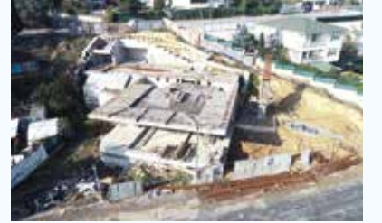
Şehitler Cami Yapım İşİ
