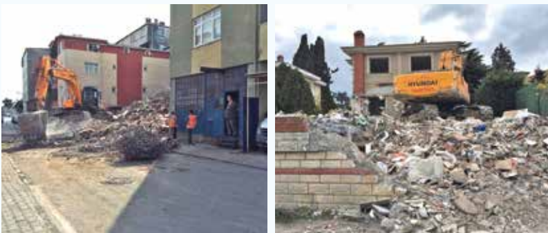
Riskli Yapıların Yıkım Çalışması
