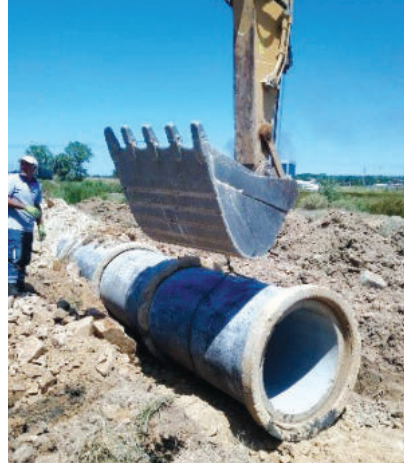
Tepeören Mahallesi Yağmursuyu Kanal Hattı Çalışması
